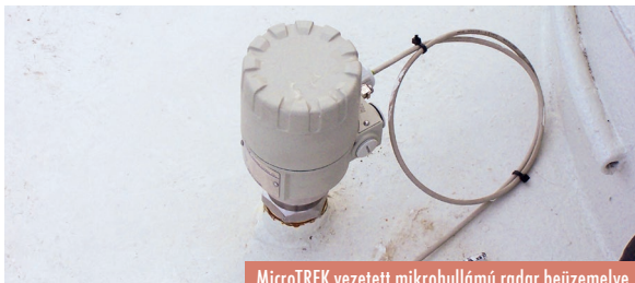
MicroTREK vezetett mikrohullámú radar beüzemelve
