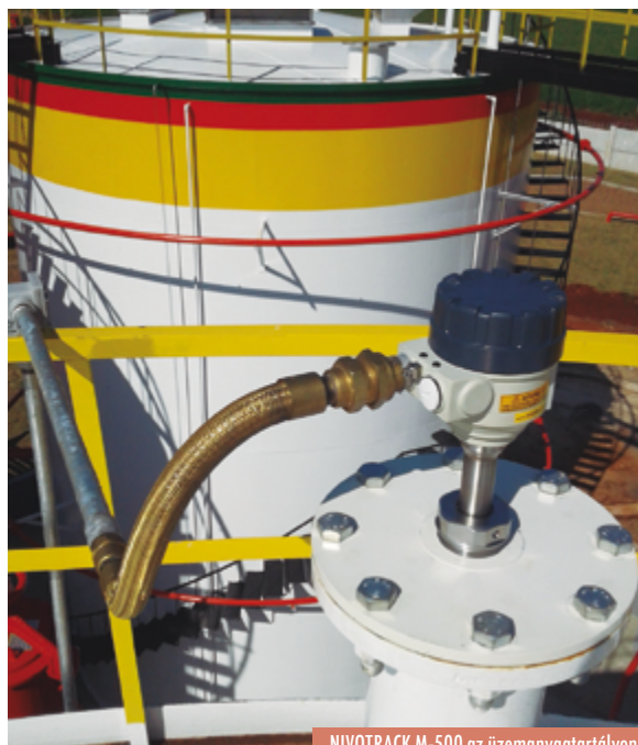
NIVOTRACK M-500 az üzemanyagtartályon
